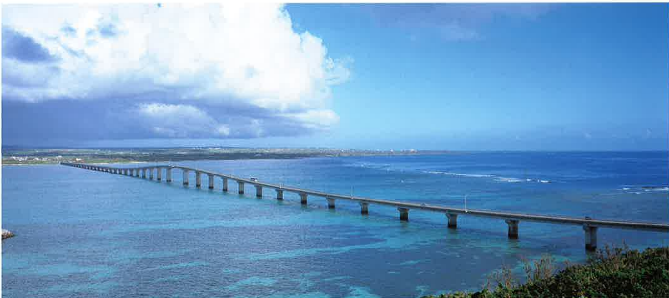
来間大橋(農道橋として整備され地域の農業振興に大きく貢献している)
