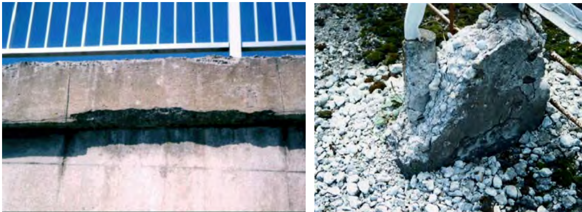
写真 2.1.9 断面欠損
