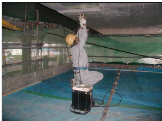
参写真 2.4.6 配筋，空洞調査状況
