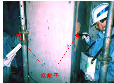
写真 3.4.4 超音波測定器による音速測定状況 柱を挟み込んで測定している
