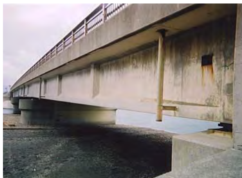
参写真 2.1.1 PC橋の側面全景
