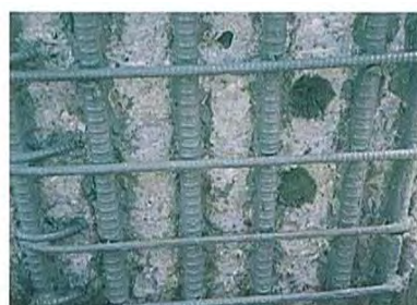
[J1ペースト施工]
