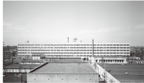
2-4-1 北棟・南棟・大教室 (現・大岡山南1号館、5号館、南講義棟) 写真50) 北棟 南面外観 (1966年) 提供: 新建築社
