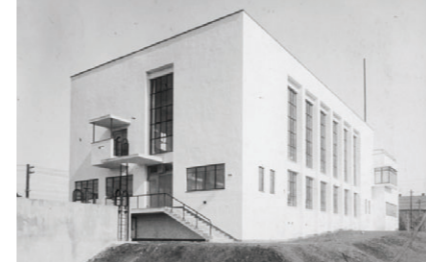
1-6-1 水力実験室 写真26) 水力実験室 南西面外観 (1932年頃)
