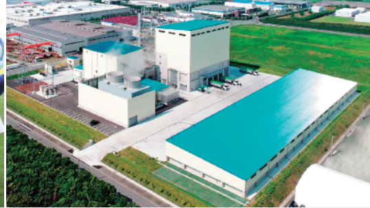
環境・地域貢献が期待される「東三河バイオマス発電所」
