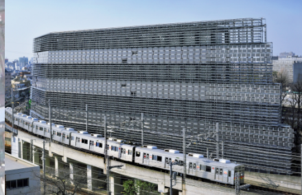
環境エネルギーイノベーション棟 (2012)
