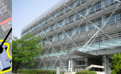
緑が丘1号館 (改修2006)
