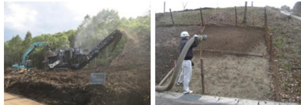
伐採した樹木のウッドチップ化 ウッドチップを法面に吹き付け散布して、浸食の防止とともに、飛来種子による緑化帯を形成
