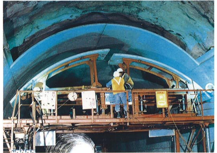
● 上部PCL版据付状況
