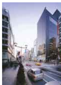
写真 2-4 シャネル銀座ビル
