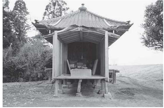
写真 拝殿が倒壊した日月堂
