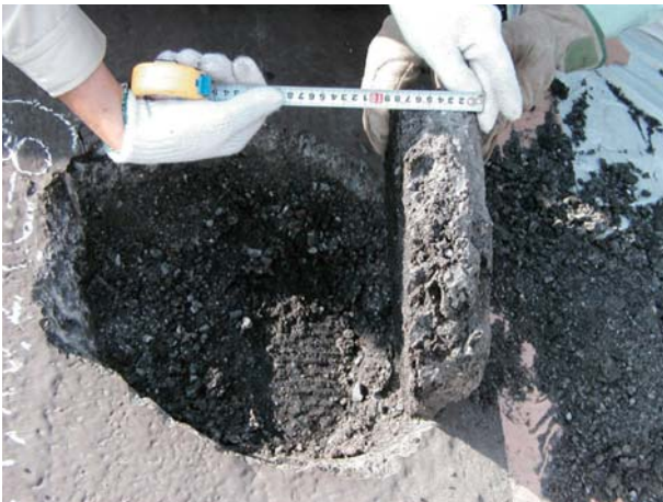
② アスファルト遮水壁のはつり調査（深山ダム）
