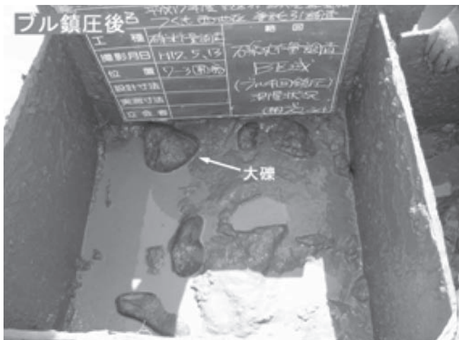
写真-2 礫沈下量調査の状況
