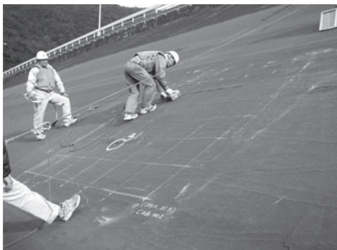
写真-4 地中レーダー探査状況
