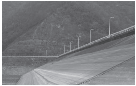
写真-2 表面遮水壁現状
