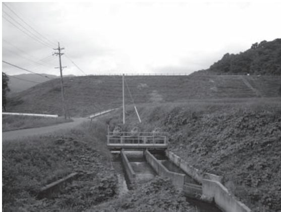
写真-3 笠田大溜の堤体と三分水
