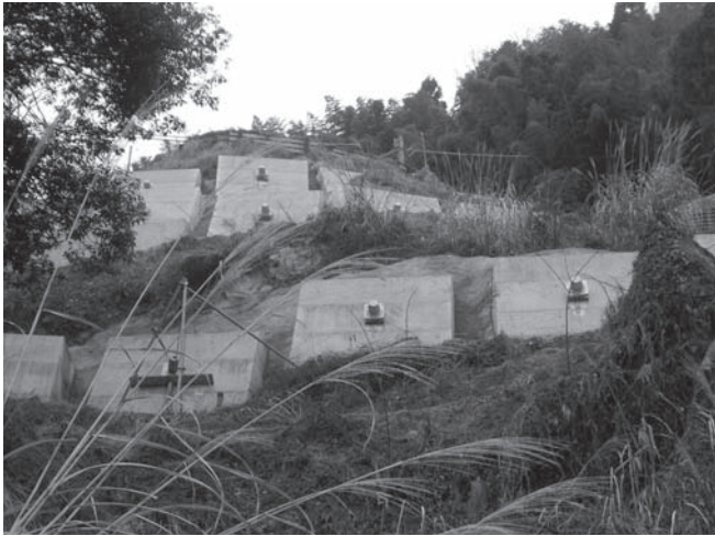
写真-2 抑止工（アンカー工）
