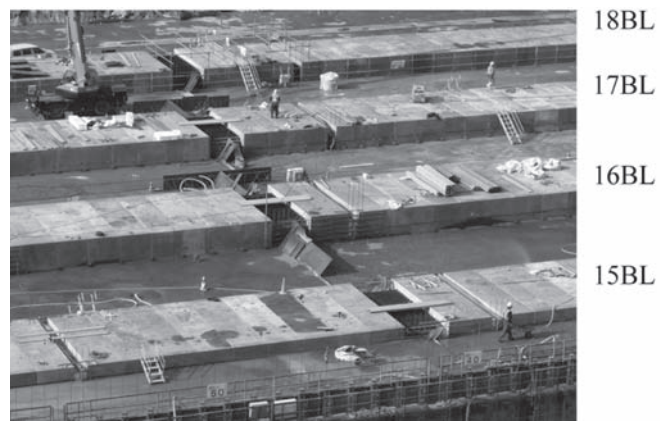
写真-1 堤内仮排水路堤頂部の施工(右:上流)
