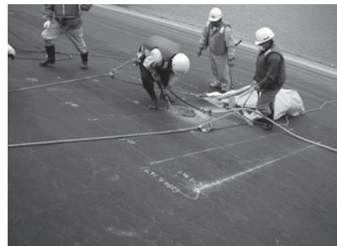
写真-5 はつり調査状況
