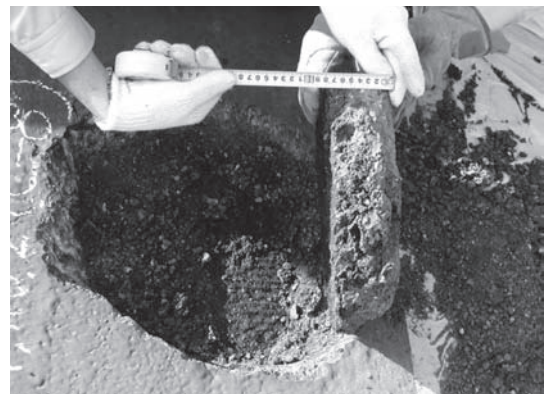
写真-6 C-8第1層剥ぎ取り状況
