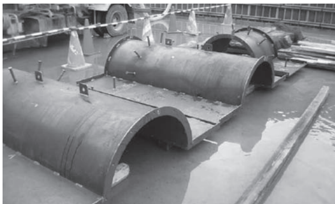
写真-2 傾斜継目ブレイク金物の設置状況
