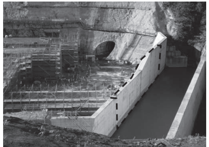
写真-3 左岸から見た1次転流擁壁撤去部(点線部)
