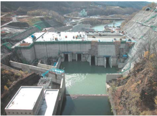
① 堤内仮排水路（夕張スーパーダム）
