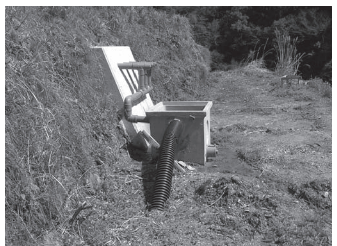
写真-1 抑制工（水抜きボーリング）
