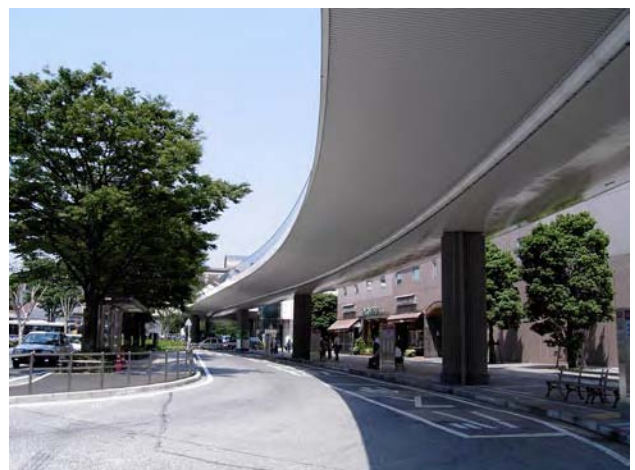
写真-4 桁下空間
