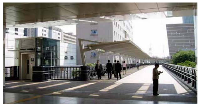
写真-5 JR川崎駅側（終点側）接続部
