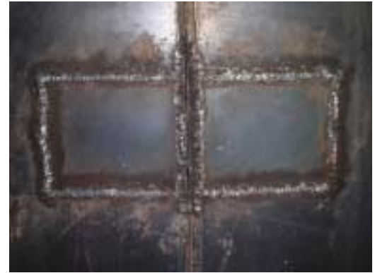
図－５ 打設用開口部
