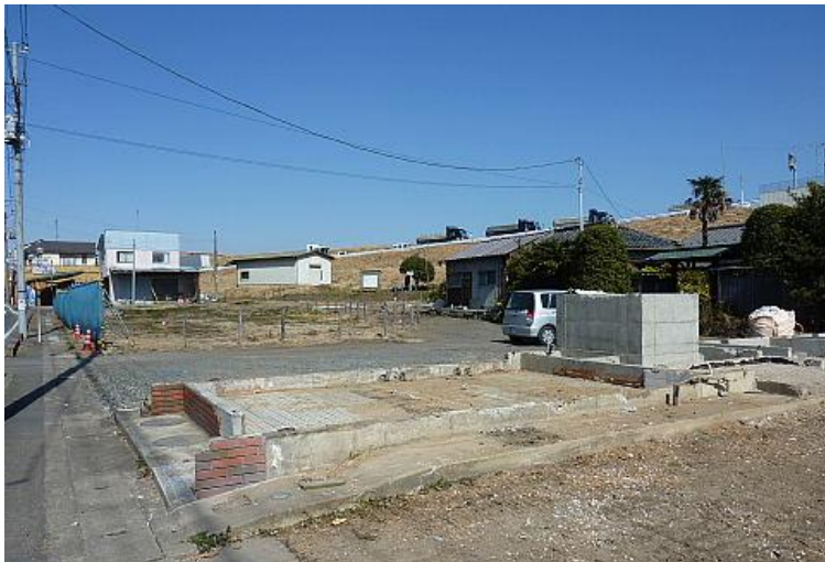
43 堤防拡張のため解体された民家跡 宿通りが消える無残な姿は 拡大する一方だという
