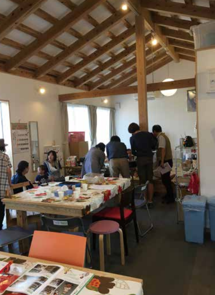
熊本地震で建設された規格型みんなの家の内観。床の仕上げが土間となっており、靴のまま入ることができる。内部には小上がりがあり、中央には県産材を活用した大黒柱がある。林業組合が寄付したベンチやテーブルも設置されている。(熊本県益城町、撮影：会誌編集委員)
