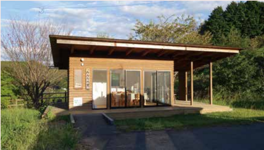
集会施設が設置されない小規模な仮設住宅団地に提供された「プッシュ型」みんなの家。小規模であるが、大きな庇空間が付随しているのが特徴。(熊本県美里町、撮影：会誌編集委員)
