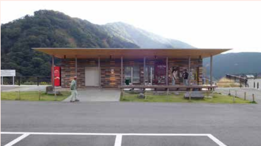
みんなの家としての役目を終え、展望施設に転用されたみんなの家。仕上げ材には仮設住宅の縁側で用いられた板が使用されている。(熊本県南阿蘇村「ヨ・ミュージウム」、撮影：会誌編集委員)
