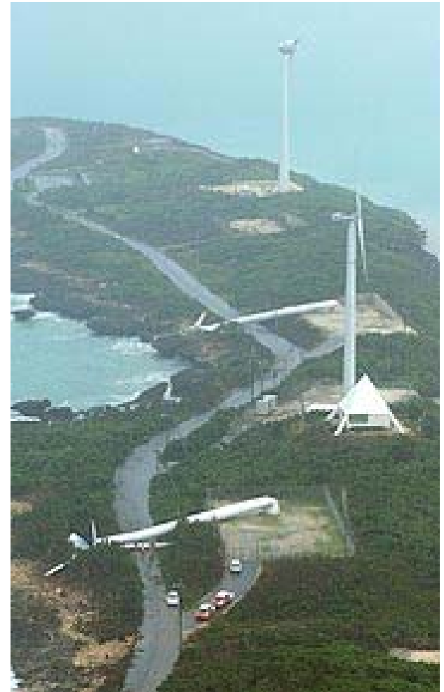
台風14号による風車被害
