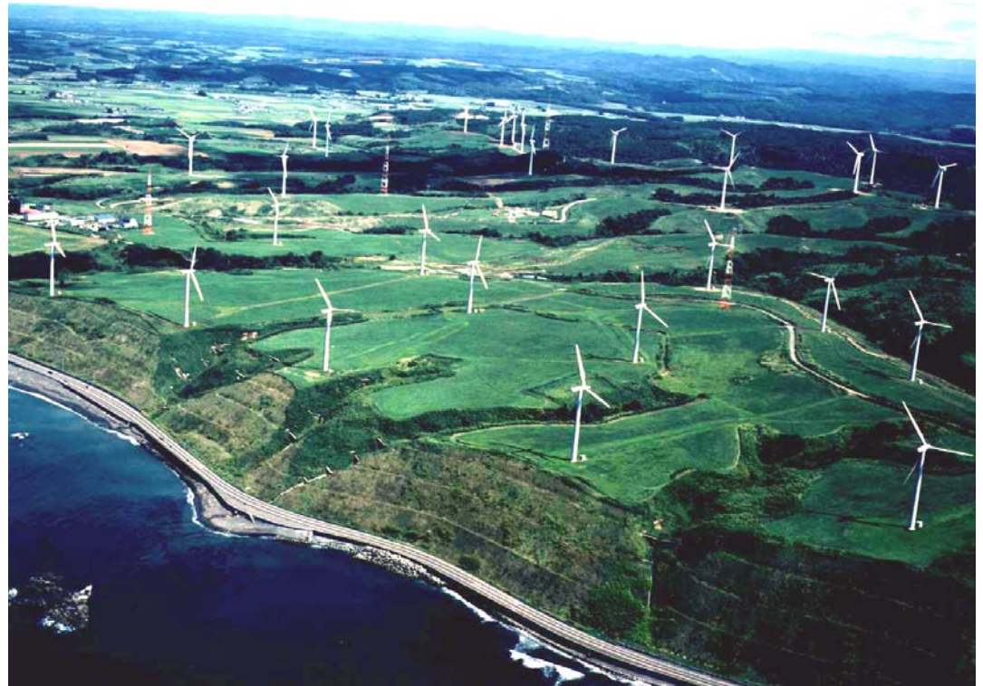
苫前町風力発電設備
