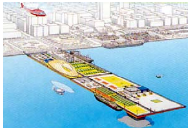
浮体式防災基地
