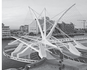
アイランドの サミュエル・ベケット橋
