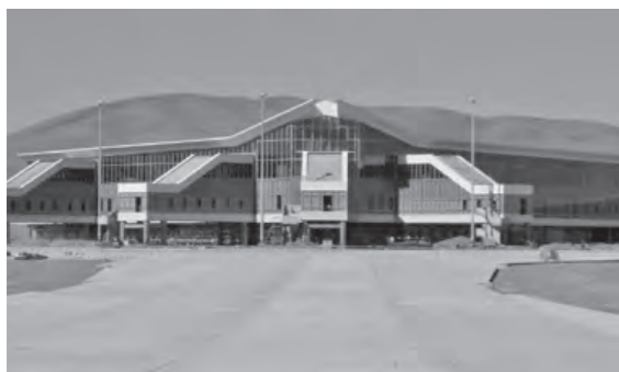
現在建設中の新ウランバートル国際空港
