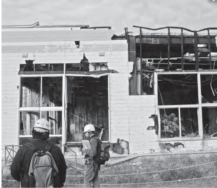
2000年噴火が始まったとき噴石の飛来により破損した幼稚園の建物
