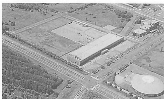
写真-1 石狩データセンター全景
