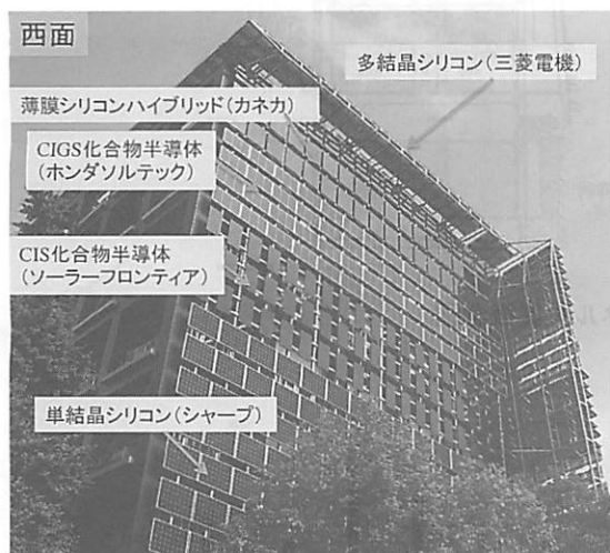
写真一 3 壁面 (西面)
