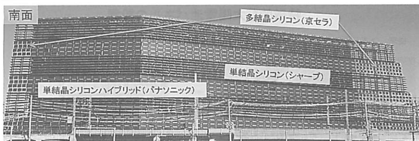
写真一 2 壁面 (南面)
