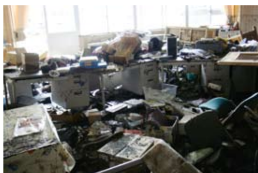
破壊され全て使えなくなった職員室
