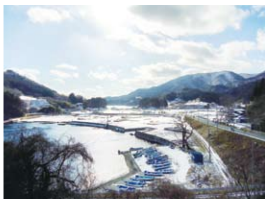
壊滅的な大沢地区・瓦礫は撤去されたが、堤防は震災当初のままである
