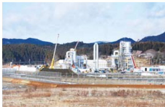
建設中のがれき焼却場 (H25.1)
