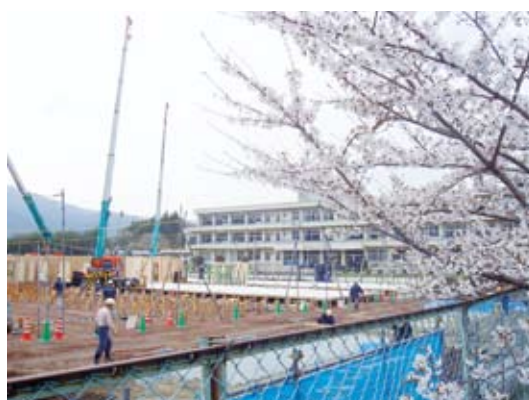
仮設住宅建設作業
