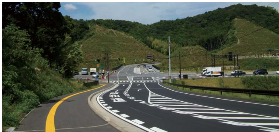
田辺西バイパス稲成川橋他道路詳細設計業務 和歌山県田辺市 国土交通省近畿地方整備局紀南河川国道事務所
