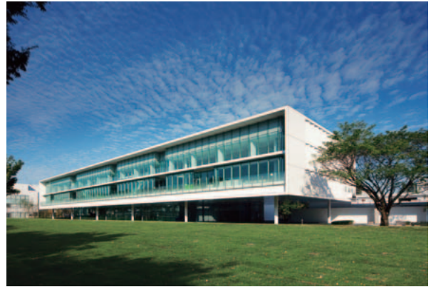
写真-1 テクノステーション外観
