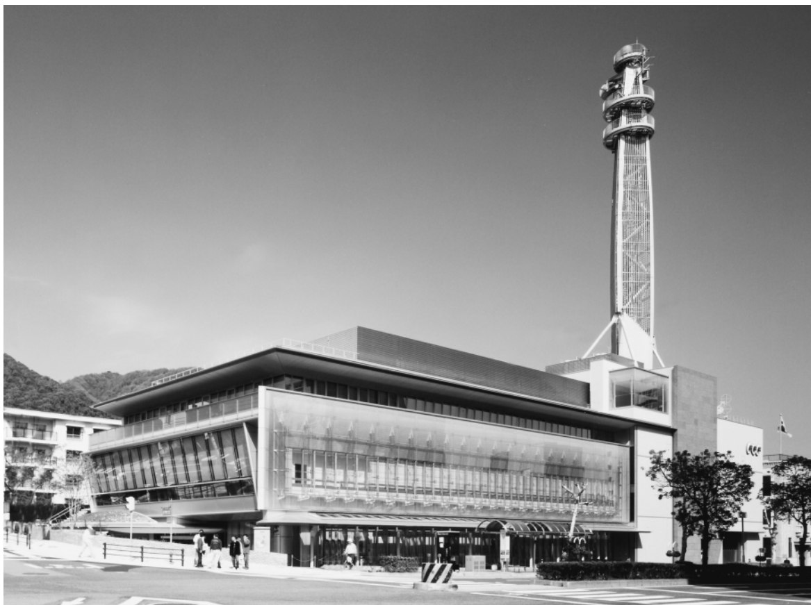
写真 - 1 建物外観(南西面から観る)
