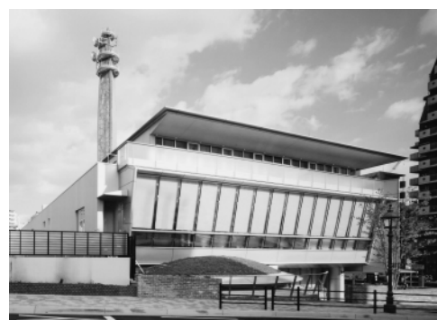
写真 - 3 西面傾斜ガラス
