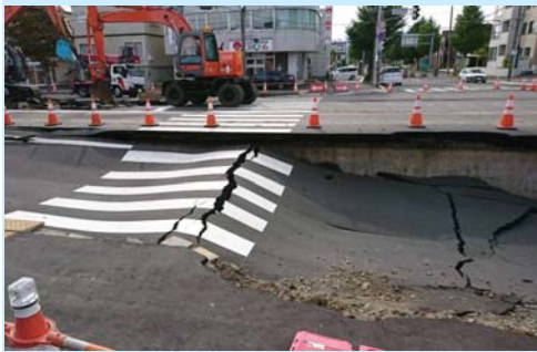
①道路の大規模沈下
