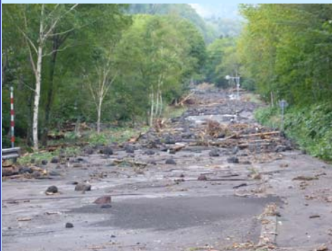
国道453号(支笏湖):平成26年9月の大雨により路面を覆う巨礫等。
