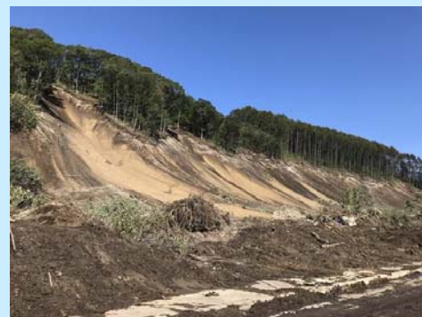
③約1.5km亘る大規模な斜面崩壊（吉野地区）
