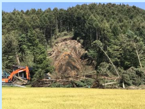
②朝日地区の斜面崩壊
