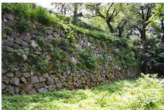
慶長14年（1609）に築かれた高岡城の石垣。 約3割が虻が島産の小境石製。矢穴や刻印が残る。
