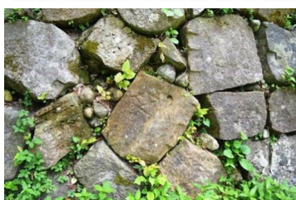
慶長14年（1609）に築かれた高岡城の石垣。 約3割が虻が島産の小境石製。矢穴や刻印が残る。
