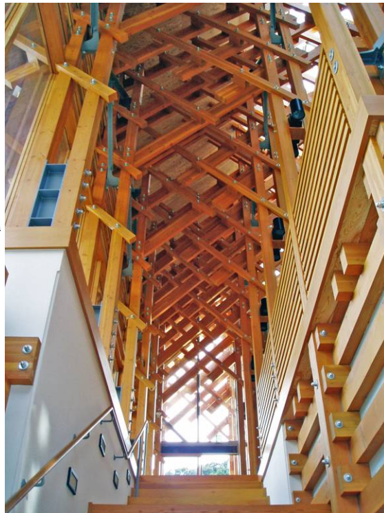
写真12：歌仙堂・階段部分見上げ
