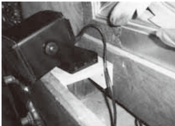
▲欄間下に設置された施工の一例
