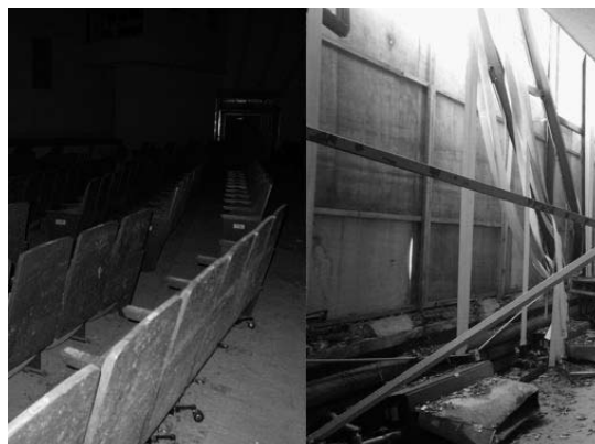
Fig.7 浸水し復旧を待つ施設 汚泥除去されたが…客席(左) 応急仮囲された展示室(右)
